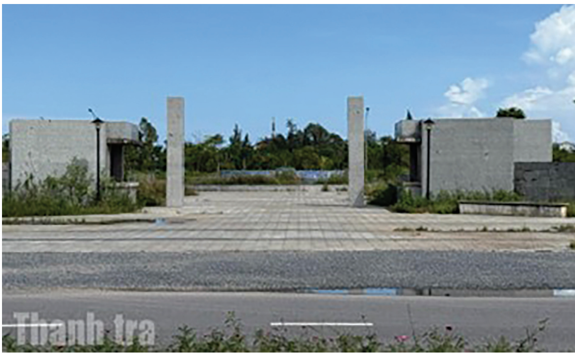
Cổng chính Công viên Cầu Rào đã hoàn thiện.
