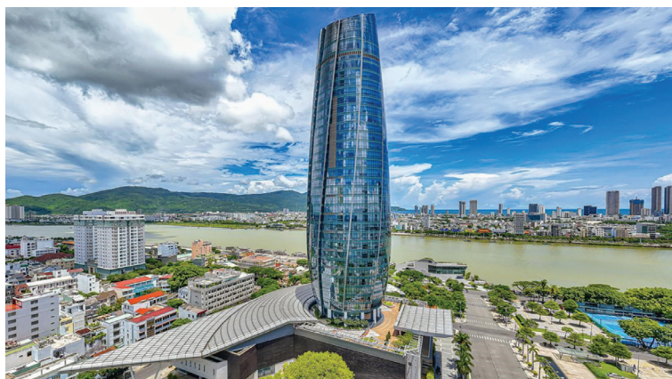
Trung tâm Hành chính thành phố Đà Nẵng.
