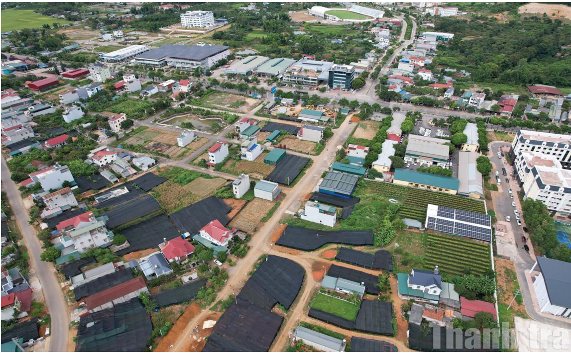
Nhiều ngôi nhà của người dân được xây dựng tại dự án của Công ty Cổ phần xây dựng và thương mại Ngọc Thanh khi chưa được cấp giấy chứng nhận quyền sử dụng đất và không được cấp phép xây dựng. Ảnh: ND
