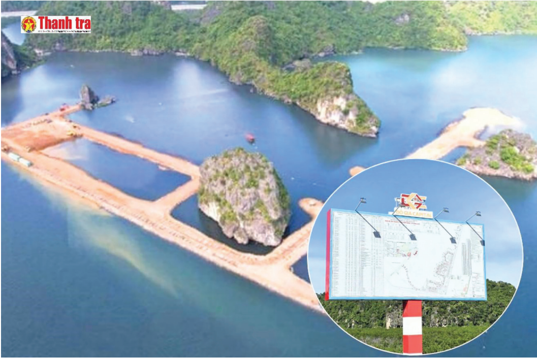
Dự án Khu đô thị tại khu 10B, phường Quang Hanh trong quá trình triển khai san lấp mặt bằng tháng 11/2023. Ảnh: Cường Vũ
